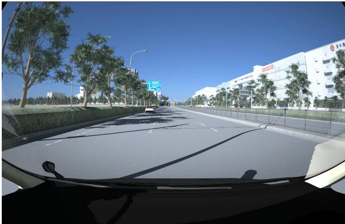
かすれた白線(お台場 青海縦貫道)
