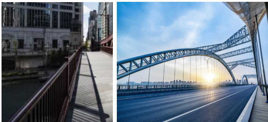
橋脚構造物によるマルチパス
